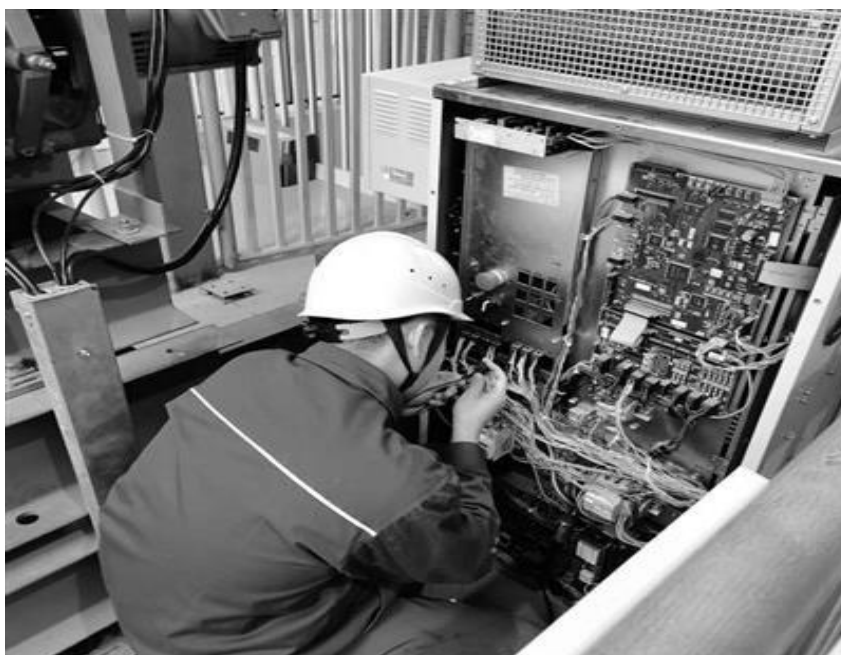
机电一体化专业学生在电梯产业学院进行维修操作
